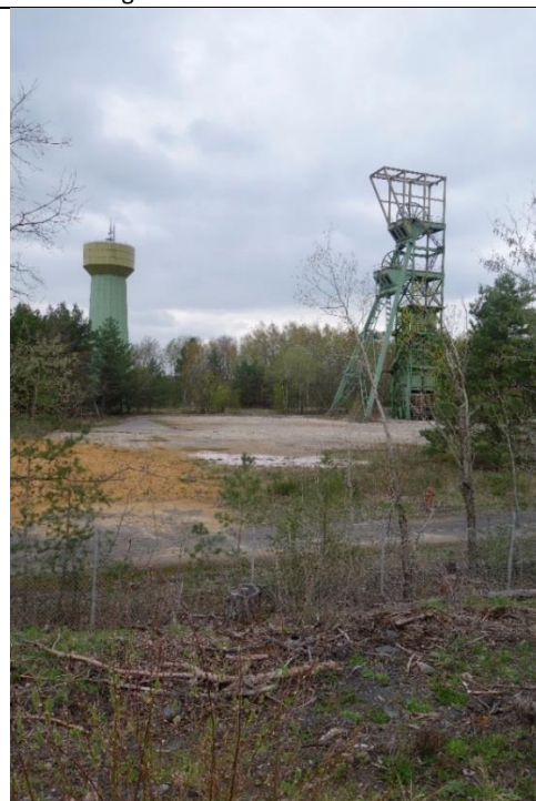
Das Gelände mit dem angrenzenden Wasserturm ist mit einem Zaun eingefriedet.
