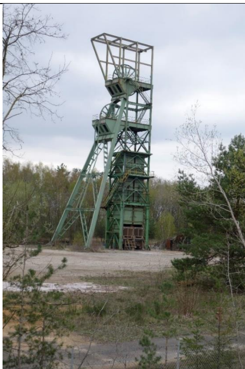
Fördergerüst St. Charles, angrenzende Gebäude und die Umbauung des unteren Gerüstteils wurden entfernt.
